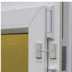
Fixierteile: den Ersten am Fensterrahmen und den Zweiten am Fensterstock im oberen Eck (unter dem Fensterbeschlag in erreichbarer Höhe) aufkleben und festdrücken.
